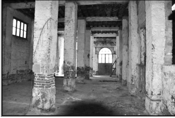
Res. No 7: Fabrika İ Mekan Alt Kat
