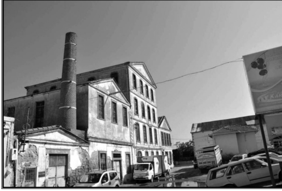
Res. No 4: Büyük Fabrika Kompleksi (Madra Zeytinyağı Fabrikası)
