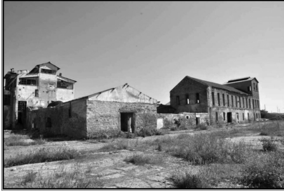
Res. No 5: Büyük Fabrika Kompleksi (Kırangıç Tesisleri Zeytinyağı, Sabun ve Prina Fabrikası)
