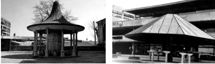
Şekil 10. Nusretiye Camii avlusu ve şadırvanı (solda), İMÇ şadırvanlı avlu (1968) (sağda).
