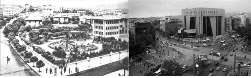
Şekil 5. Kızılay parkı ve binası eski-yeni karşılaştırması (Kızılay Binası, 2015; Çankaya Belediyesi, 2015)
